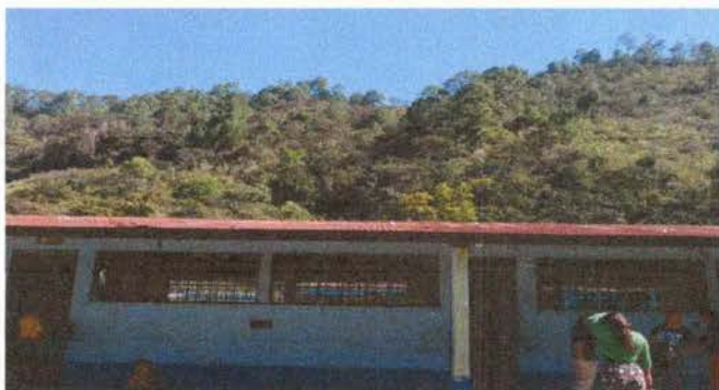
Foto1: Sustitución de laminas en mal estado modulo 1.
